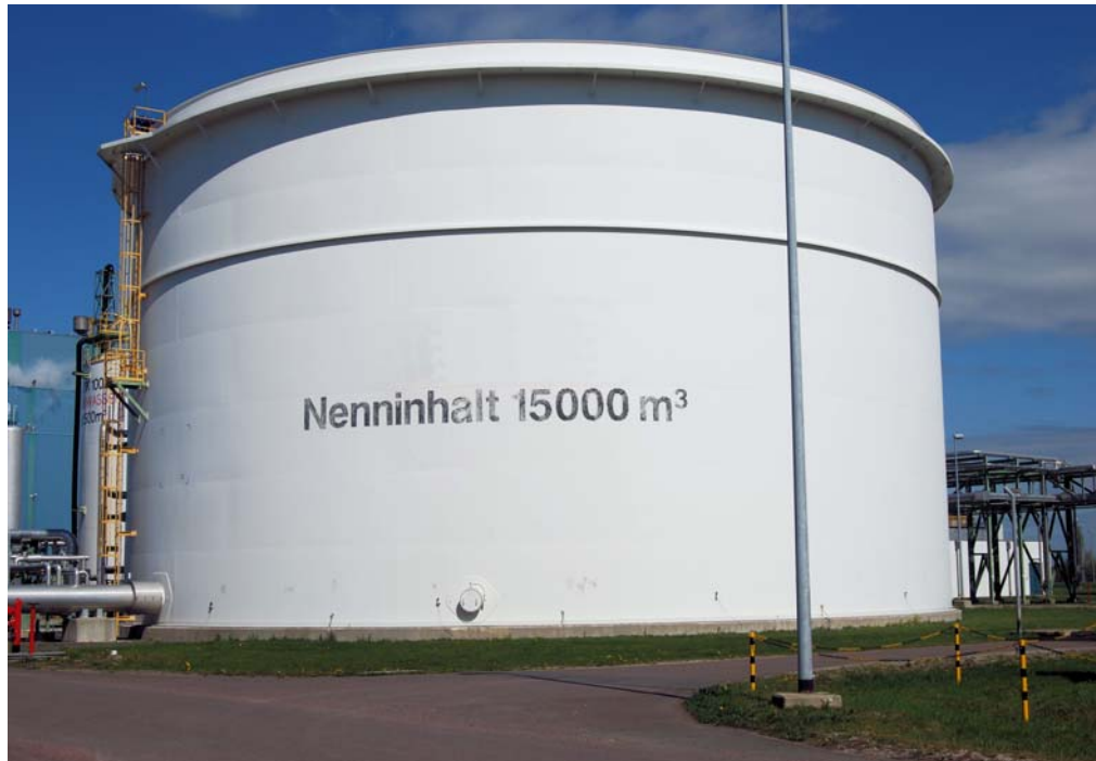
Abb. 4 Lagertank für erste Testmessungen
